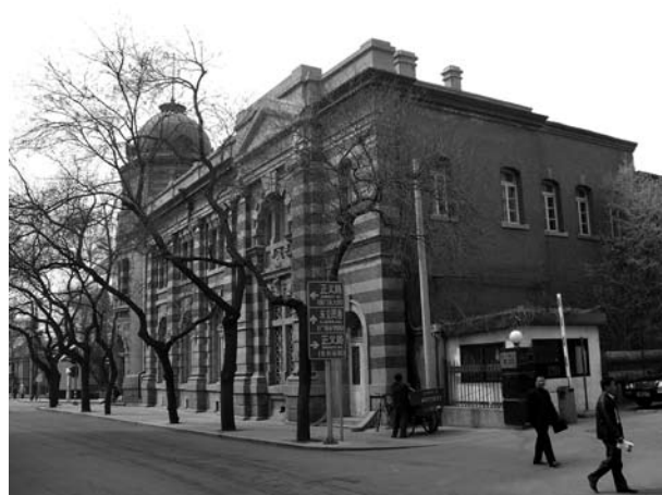
I denna byggnad i hörnet av Dongjiaomin xiang och Zhenyuan lu låg en gång Yokohama Specie Banks huvudkontor i Peking. Idag finns här en kinesisk bank. Foto BL.
